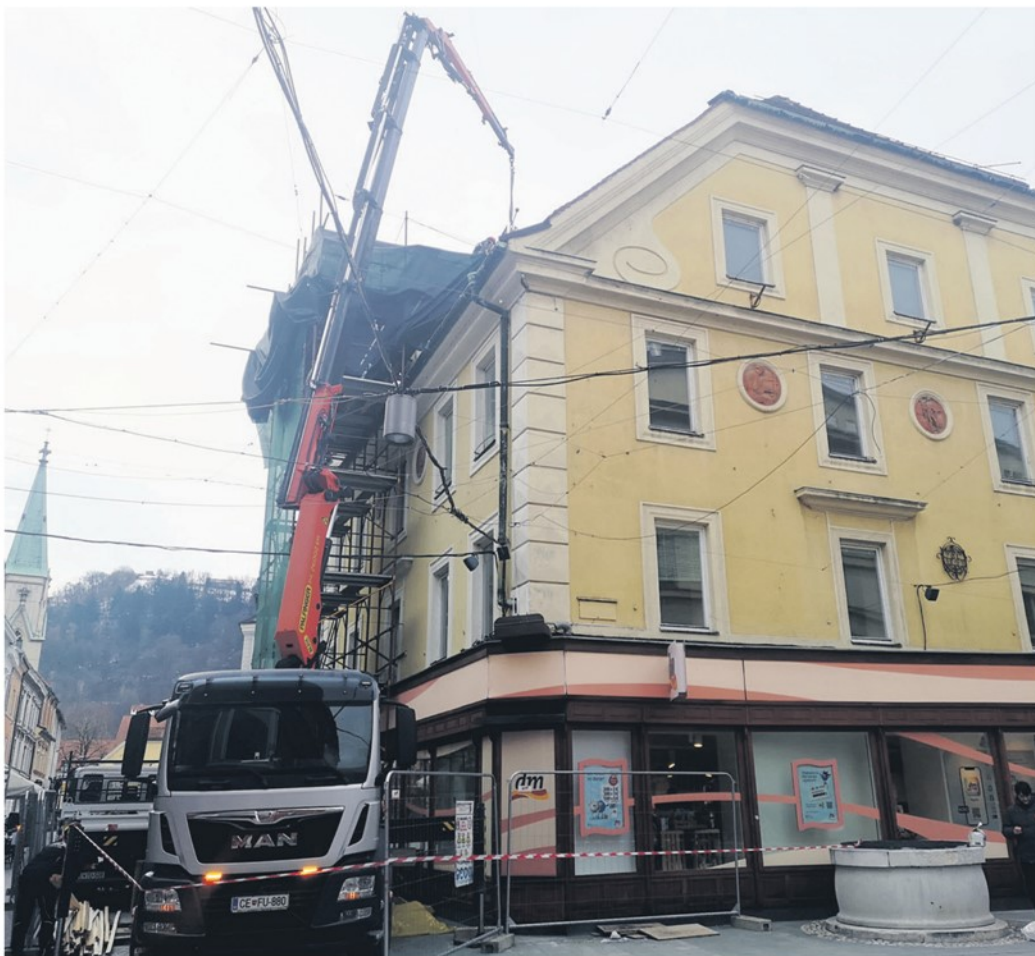
Podjetje Merkscha furnirnica je lastnik znamenite stavbe na celjskem mestnem križu od leta 2018. Kdaj jo bo lahko začelo obnavljati in kakšna bo njena nova vsebina, še ni dokončno določeno. Te dni je odstranilo le nadzidek na strehi, ker je obstajala nevarnost, da bi se porušil. (Foto: JI)
